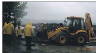
Budowa w Kłodzku ruszyła. Na jej teren wjechał już ciężki sprzęt.
